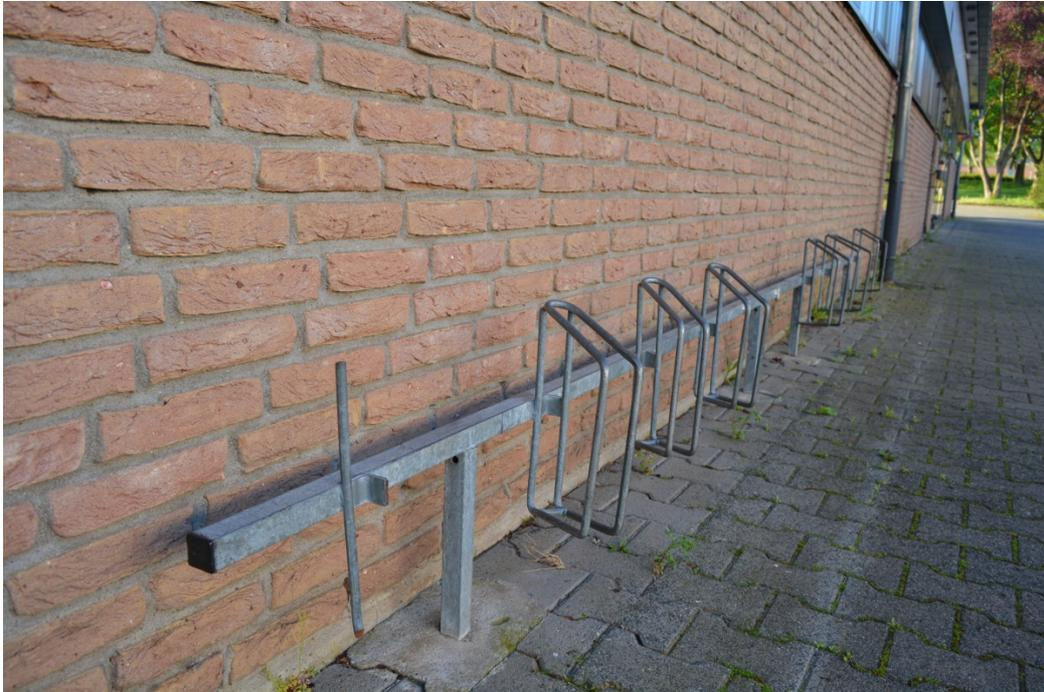
Foto 1: Felgenkiller an der Nidderhalle. Kippt das Fahrrad, verbiegt die Felge. Zudem kann nur mit dem Vorderrad angeschlossen werden, das flinke Diebe einfach abmontieren können.
